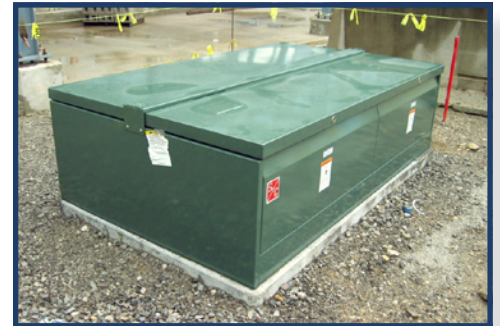
SWITCHGEAR BASE
