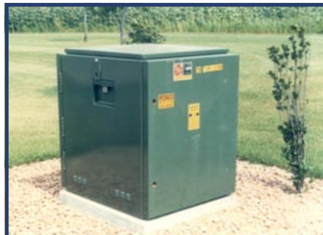
SWITCHGEAR BASE
